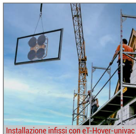
Dispositivo di sollevamento per l'industria del vetro
